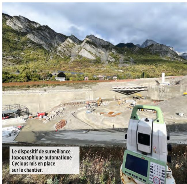
Le dispositif de surveillance topographique automatique Cyclops mis en place sur le chantier.
