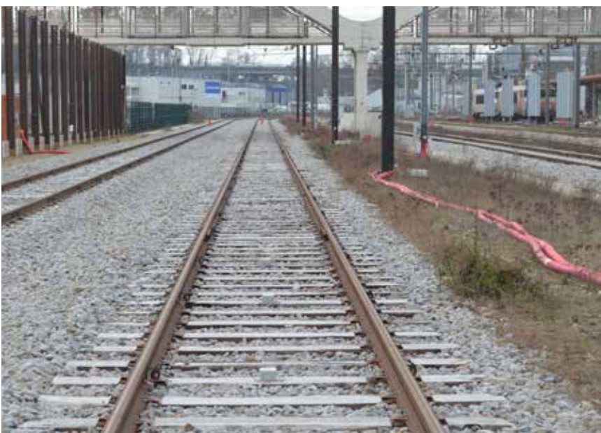
Dispositif Rail Serenity installé sur les rails du faisceau ferré au droit de la future gare de Massy-Palaiseau.
