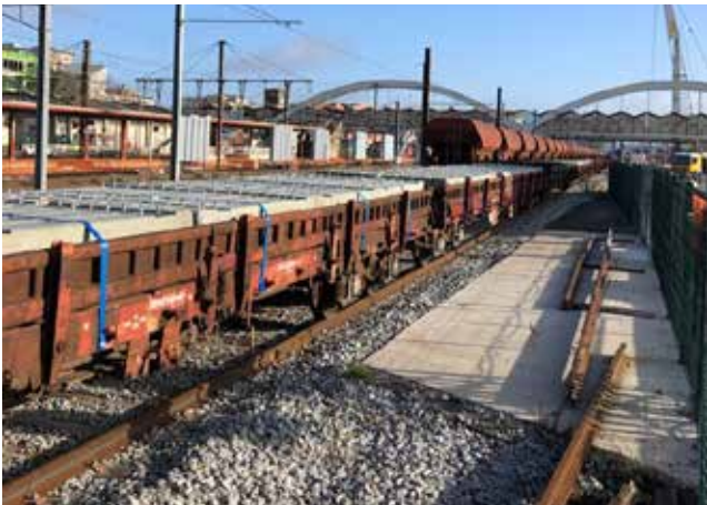
Gare de Massy-Palaiseau : la circulation des trains n'est pas interrompue pendant les travaux du Grand Paris Express.
